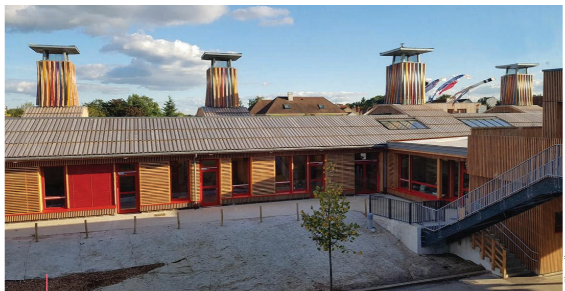
Ecole des Boutours à Rosny-sous-Bois (93) - Réhabilitation
