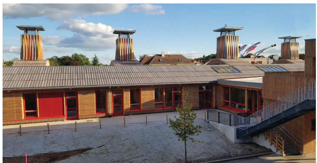
Ecole des Boutours à Rosny-sous-Bois (93) - Réhabilitation
